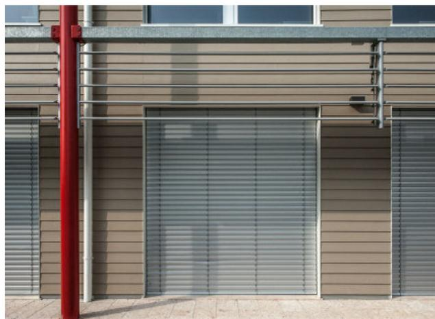
Il nuovo plesso scolastico è costituito da un edificio a due piani fuori terra con 12 aule ed è stato progettato con la previsione di un futuro ampliamento. L'involucro, volutamente compatto allo scopo di ottimizzare il rapporto S/V, è costituito da chiare e semplici forme lineari ripartite da pilastri di colore rosso ai quali sono fissati i frangisole.
