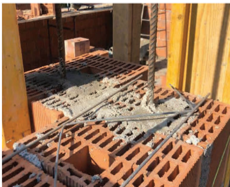
Armatura orizzontale con traliccio tipo "Murfor"
