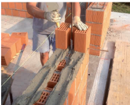
Posa in opera blocco tipo "Brite"
