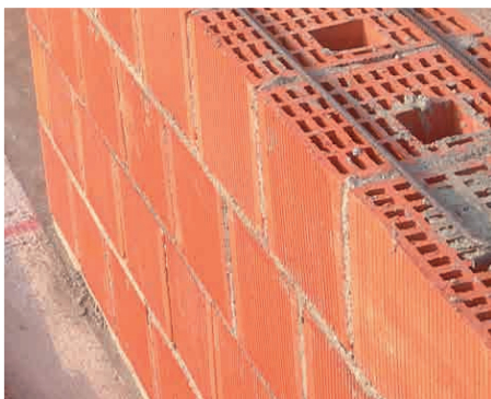
Porzione di parete con blocchi tipo "Brite"
