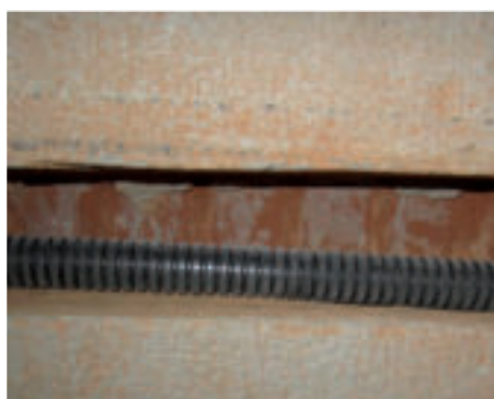
Traccia per impianto elettrico
