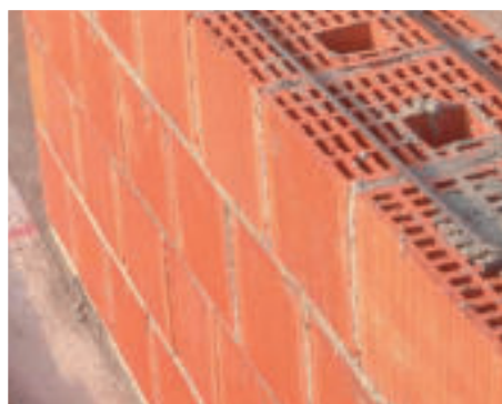
Porzione di parete con blocchi tipo "Brite"
