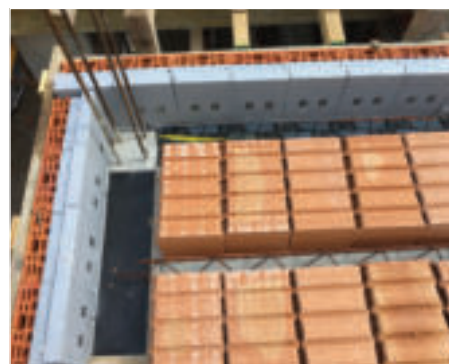
Funzione cassero del solaio
