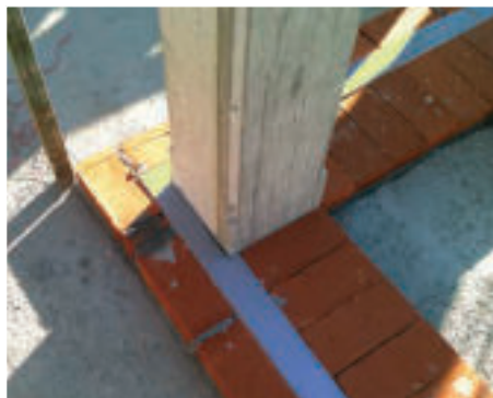
Preparazione del piano di posa
