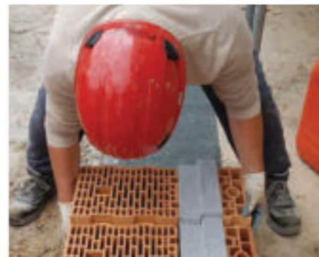
Posa in opera elemento base
