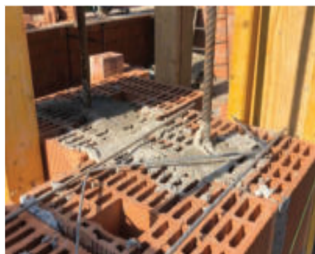
Armatura orizzontale con traliccio tipo "Murfor"
