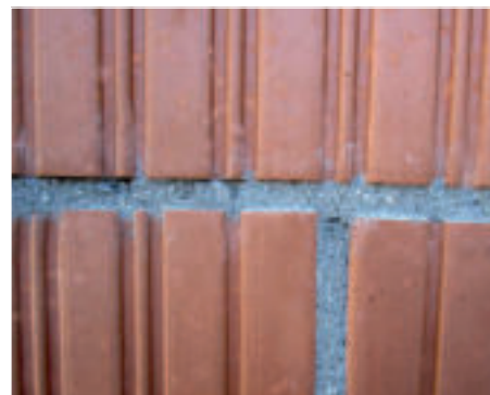
Giunti verticali blocco acustico liscio 30x30x19
