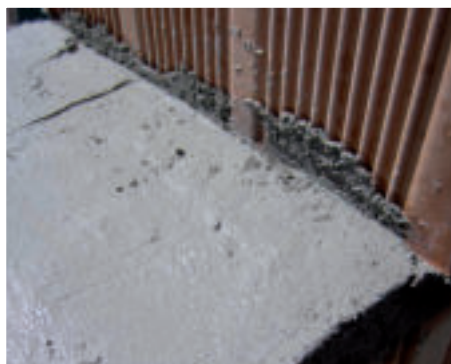
Giunti di malta orizzontali completamente riempiti
