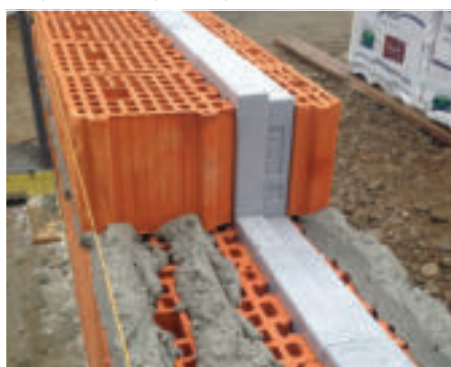
Posa in opera elemento base
