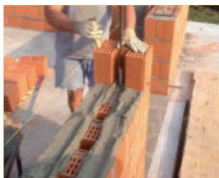
Posa in opera blocco tipo "Brite"
