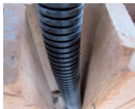
Traccia per impianto elettrico
