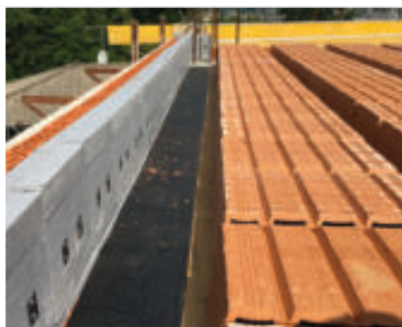
Funzione cassero del solaio
