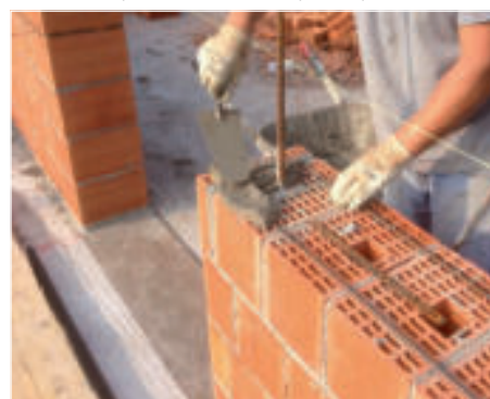
Spalletta di porta
