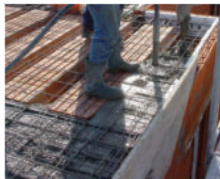
Getto del solaio
