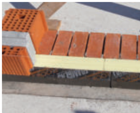
Preparazione del piano di posa
