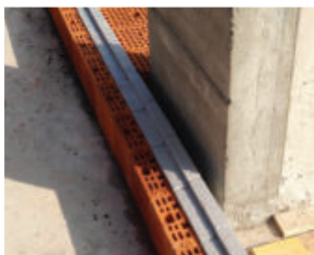
Coibentazione del pilastro con copricordolo
