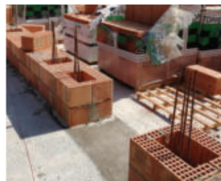
Spalletta di porta
