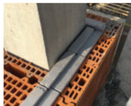
Coibentazione del pilastro con copricordolo
