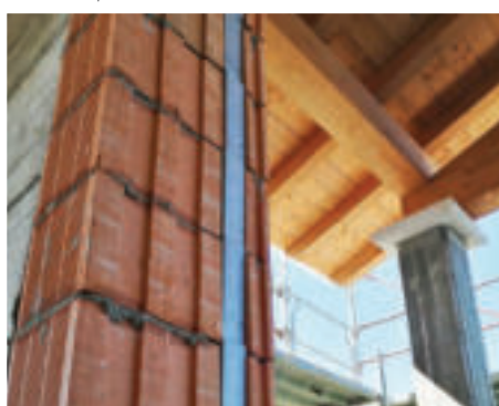
Spalletta di porta
