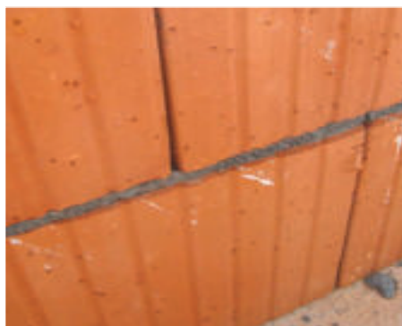
Particolare giunti di malta
